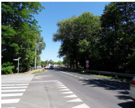
Fot.8.13 Miejsce gdzie pod drogą przepływa rzeka Wirenka
