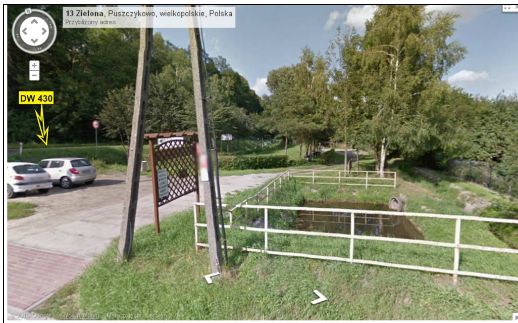
Ryc. 10.1 Szczelny zbiornik ścieków z kanalizacji deszczowej przy DW 430 w km ok. 7+600
