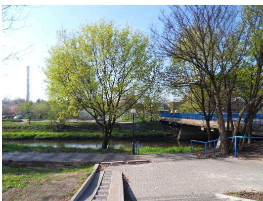
Fot.7.45 Most nad Kanałem Mosińskim w okolicy końca projektowanej inwestycji.
