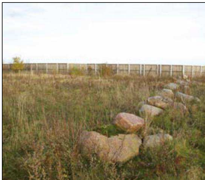
Fot.8.15 Przykład rzędu głazów na przejściu dla zwierząt górnych – podobnie używa się ich przed wylotami przejść dolnych
